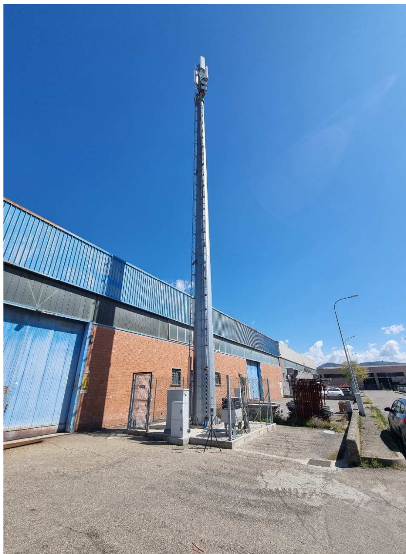
Foto 1 – Vista complessiva dell'area di intervento
